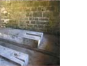
Generator plant in the Storehouse. Plateforme pour générateurs à l'intérieur du Magasin.
