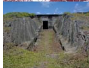
Entrance to the Underground Generator Hall. Entrée de la Salle de Générateurs.
