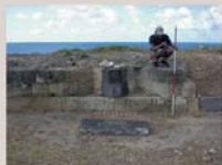
Upper Battery emplacement with twin niches and flag staff. Emplacement de tir sur la Batterie Supérieure avec niches jumelées et fune des perches de boussole supérieure à terre.
