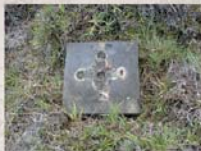
Une joint fitted in a basalt block for a Gribeauval traversing platform. Point de fixation dans un bloc de basalte, pour plateforme Gribeauval.
